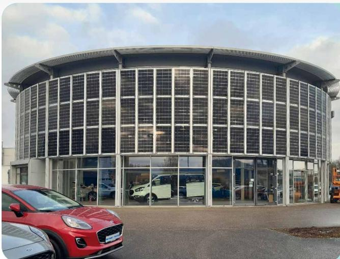
Das rahmenlose Photovoltaik-Glas hat eine Transparenz von etwa 28%. Dadurch wird eine angenehme Verschattung realisiert. Die Module bieten Spielraum mit Licht- und Sonnenschutz. Für die nötige Robustheit sorgen zwei Gläser mit 4 mm Stärke als Vorder- und Rückseite. Dank des verwendeten Sicherheitsglases sind die Module durch das DIBt sowohl zur Überkopfmontage als auch zur Vertikalverglasung zugelassen.
